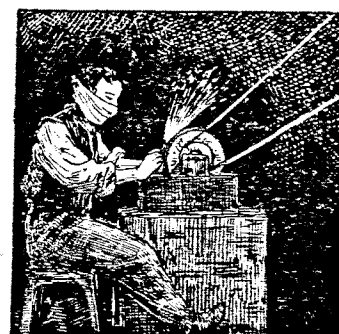
32-33. Aiguille et ouvrier aiguissant paquet d'aiguilles.
