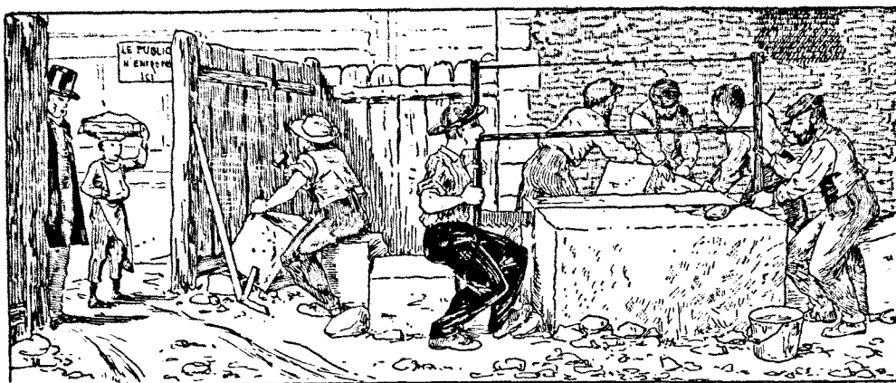
26. Tailleurs de pierre taillant et sciant de la pierre à bâtir.
