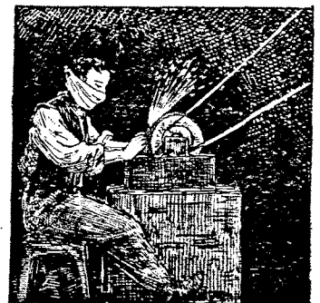
32-33. Aiguille et ouvrier aiguisant un paquet d'aiguilles.
