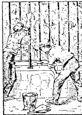
5. Ouvrier scellant* , au moyen du plomb, du fer dans la pierre. (Voir fig. 6.) De cette façon le fer fait corps avec la pierre.
