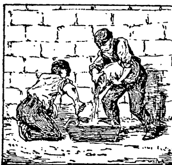
77. Lorsqu'on gâche* avec de l'eau du plâtre en poudre, on forme une bouillie qui durcit peu à peu.
