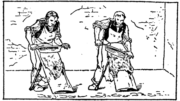
40. On laisse les peaux pourrir un peu. On n'a alors qu'à les racler pour enlever les poils.
